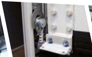
Paracadute cavi Cable break safety device Seilbruchsicherungsvorrichtung
